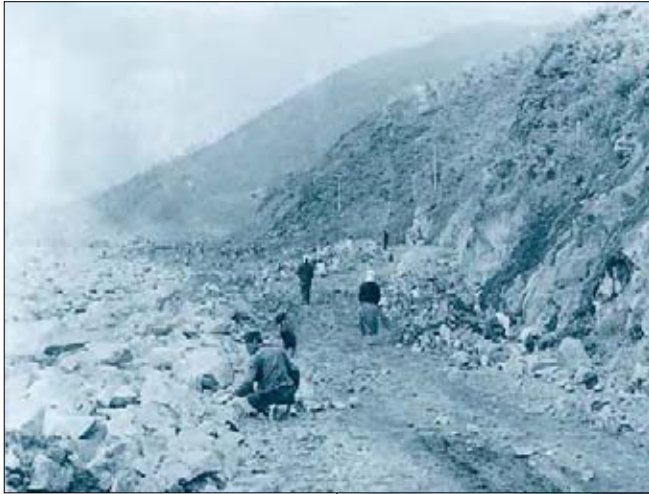
◀ 설악산 C지구 설악교 앞 (63. 9. 7 준공된 포장공사 이전)
