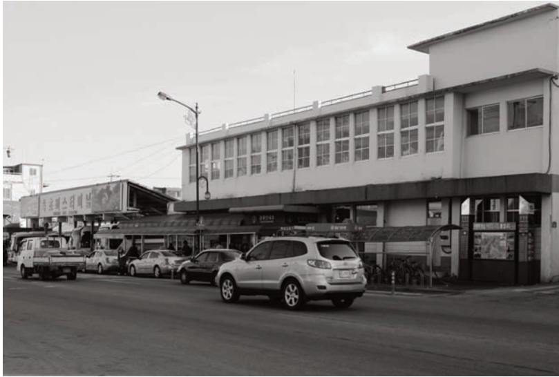
리모델링하기 전 속초시외버스터미널 외관
