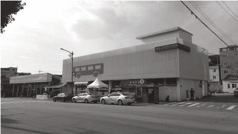
리모델링한 후 현재 속초시외버스터미널 외관
