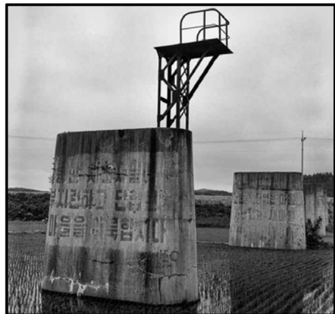
<사진 46> 동해북부선 양양 남대천 철교 교각
