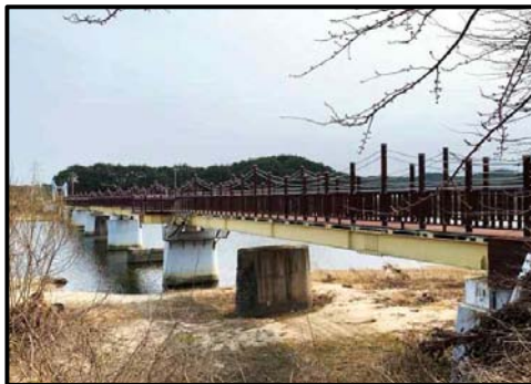
<사진 45> 동해북부선 고성군 북천 철교 교각
