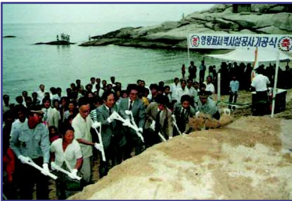
1985년 9월 영랑동 파제벽시설 공사 기공식
