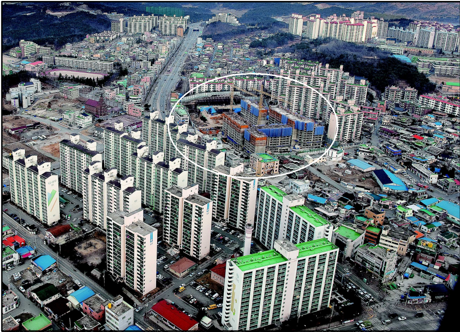
〈사진 12〉 하우스토리 아파트 공사 모습
