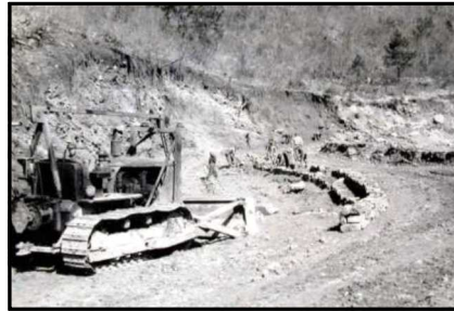
<사진 60> 미시령 도로 개설 공사중(1959) 65)
