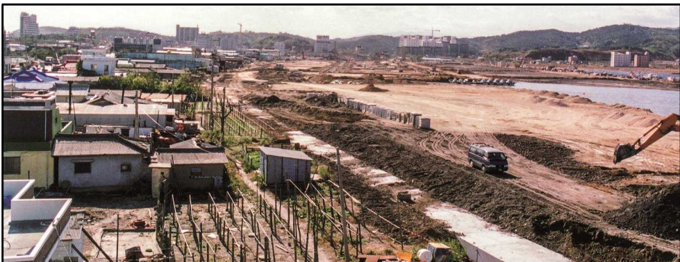
<사진 7> 청초호 청호동 쪽 매립공사 현장
